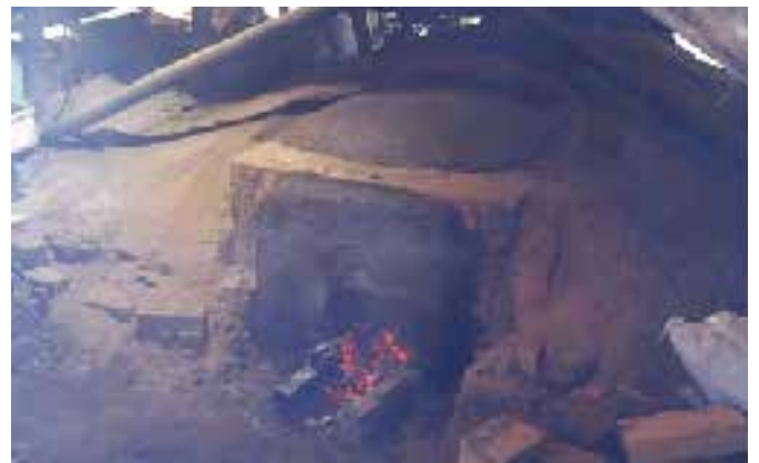
修繕後の炭窯の様子
