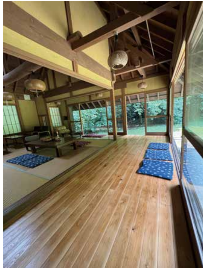
塗装後の縁側
