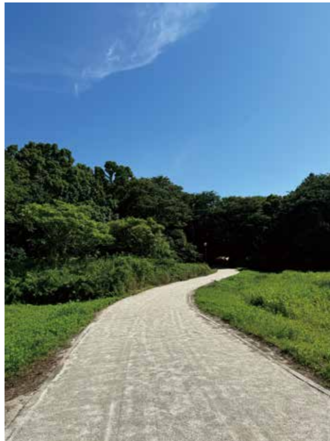
補修後の園路の様子
