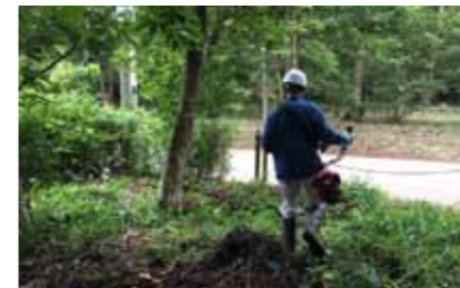
道路沿いの藪を刈り見通しをよくする様子
