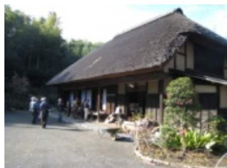
移築された古民家で昔の生活を紹介
