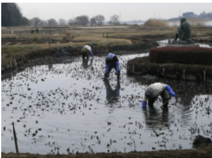
アヤメ園スイレン池のヘドロ浚渫作業
