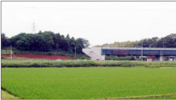
建設中の圏央道
