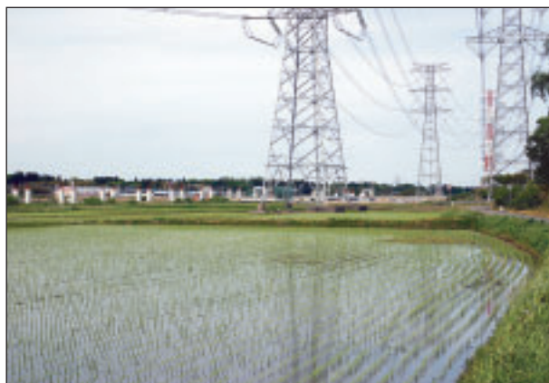
建設中の圏央道
